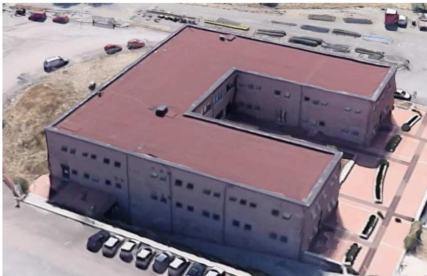
L'edificio B è un fabbricato di pianta regolare ad "U", sviluppato prevalentemente su 2 piani fuori terra ed un piano interrato. L'altezza interna dei piani è di circa 2,7 metri di media.
