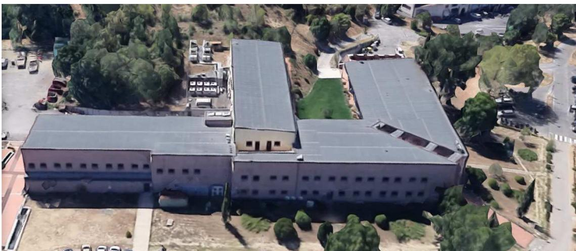
L'edificio A è un fabbricato di planimetria regolare ad "F", edificato su terreno in pendenza. Si sviluppa su 3 livelli: Piano Terra, Piano Semi-Interrato e, sull'ala centrale, Piano Primo (c.a 350 mq). L'altezza interna dei piani è circa 2,7 metri.
